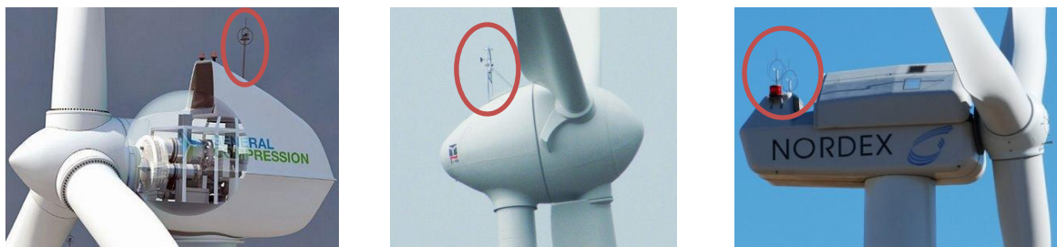
Figura 3.9 – Posicionamento do anemómetro da nacelle em diferentes aerogeradores
