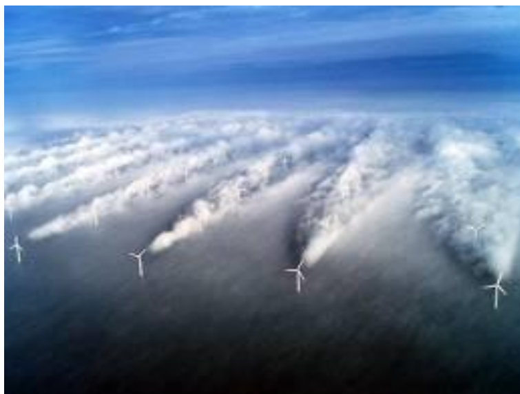
Figura 3.5 – Efeito de esteira no parque eólico offshore de Horns Rev, Dinamarca
